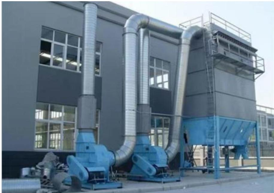
袋式除尘器优点袋式除尘器对净化含微米或压微末数量级的粉尘粒子的气体效率较高，一般可达99%，甚z可达，特别是高比电阻粉尘，采用袋式除尘器净化要比用电除尘器的净化效率高很多；含尘气体浓度在相当大的范围内变化对袋式除尘器的除尘效率和阻力影响不大；袋式除尘器可设计制造出适应不同气量的含尘气体的要求，除尘器的处理烟气量可从每小时几立方米到几百立方米。袋式除尘器也可做成小型的，安装在散尘设备上或散尘设备附近，也可安装在车上做成移动式袋式过滤器，这种小巧、灵活的袋式除尘器特别适用于分散尘源的除尘；袋式除尘运行稳定可靠，没有污泥处理和腐蚀等问题，操作、维护简单。
