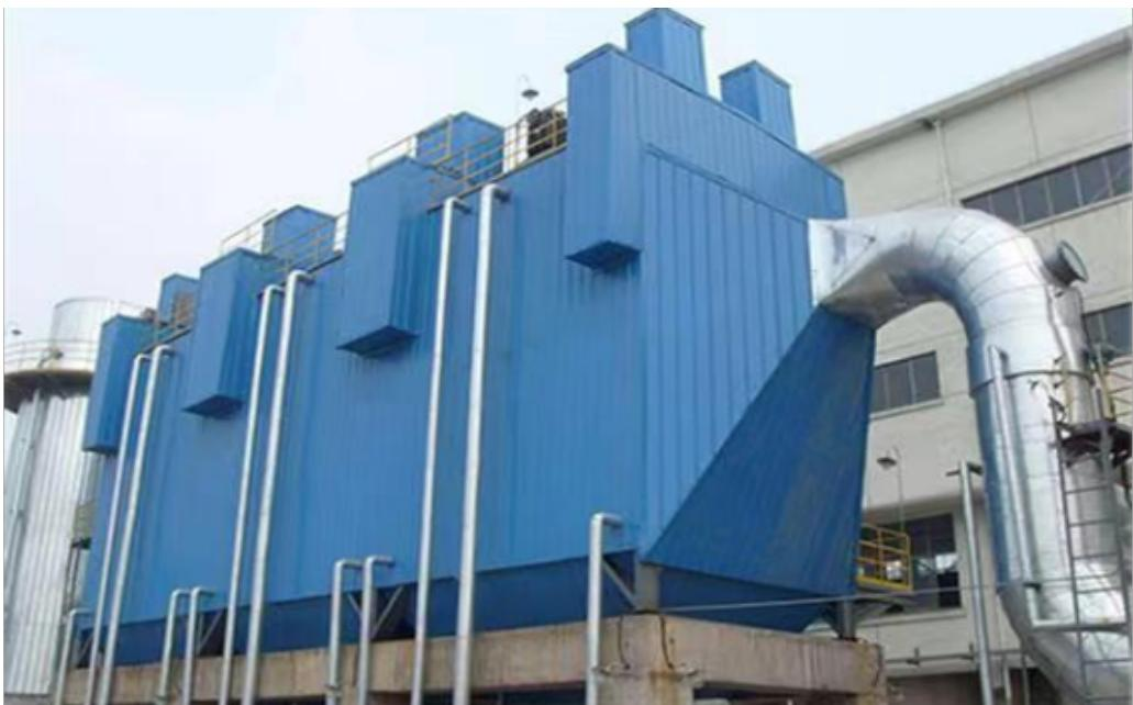
旋风除尘器旋风除尘设备是利用气体加速旋转而产生离心力，旋转的固体粉尘从气体中分离出来的原理进行除尘的设备。用途:适用于各种工业锅炉，机械加工，冶金建材，铸造，矿山，水泥，采掘的粉尘粗、中级净化。湿式除尘器湿式除尘器的类型，从不同角度有不同的分类：按结构型式可分为贮水式湿式除尘器、加压水喷淋式及强制旋转喷淋式湿式脱硫除尘器；按能耗大小可分为低能耗及高能耗；按气液接触式可分为整体及分散接触式湿式除尘器等。用途:适用于冶金、煤炭、化工、铸造、发电、建筑材料及耐火材料等行业。脱硫除尘器脱硫除尘器主要是烟气通过不锈钢散堆填料，增加了烟气与水溶液的接触面，加速了烟气与喷淋水的充分溶解中和，提高了除尘装置的除尘脱硫除尘效率。
